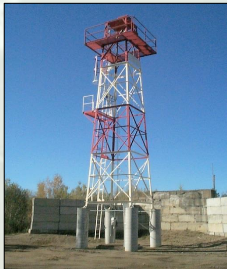
Tour de chute de 12 mètres (40 pieds).
