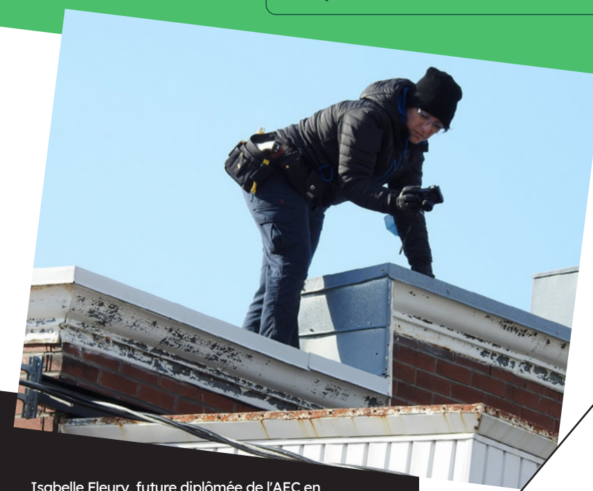
Isabelle Fleury, future diplômée de l'AEC en Techniques d'inspection de bâtiments.
